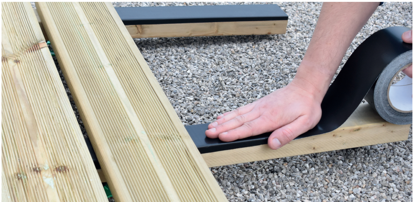
Étanchéité des lambourdes bois sous terrasse
