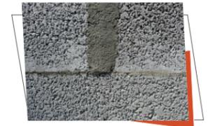
De 3 mm à 5 cm mortier isolant (type Batiponce ou 159 Lankotherm)
